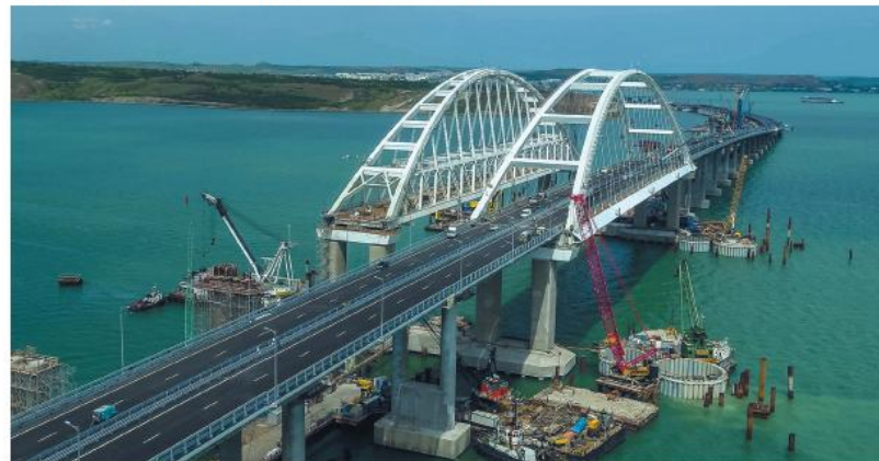
Строительство Крымского моста
